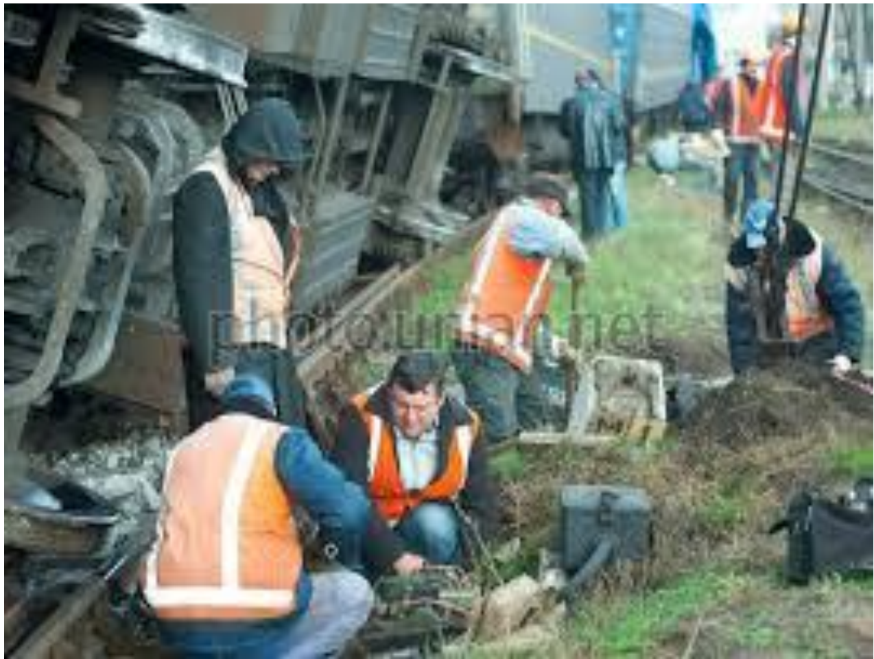
Рисунок 2 – Роботи по ліквідації наслідків аварії на залізничному транспорті
