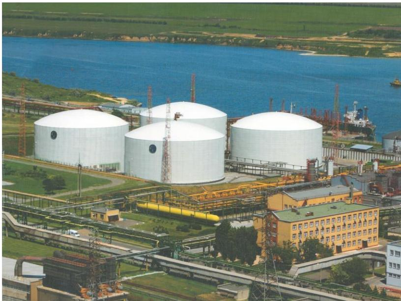
Рис. 1. Ёмкости для изотермического хранения аммиака на ОАО «Одесский припортовый завод»
