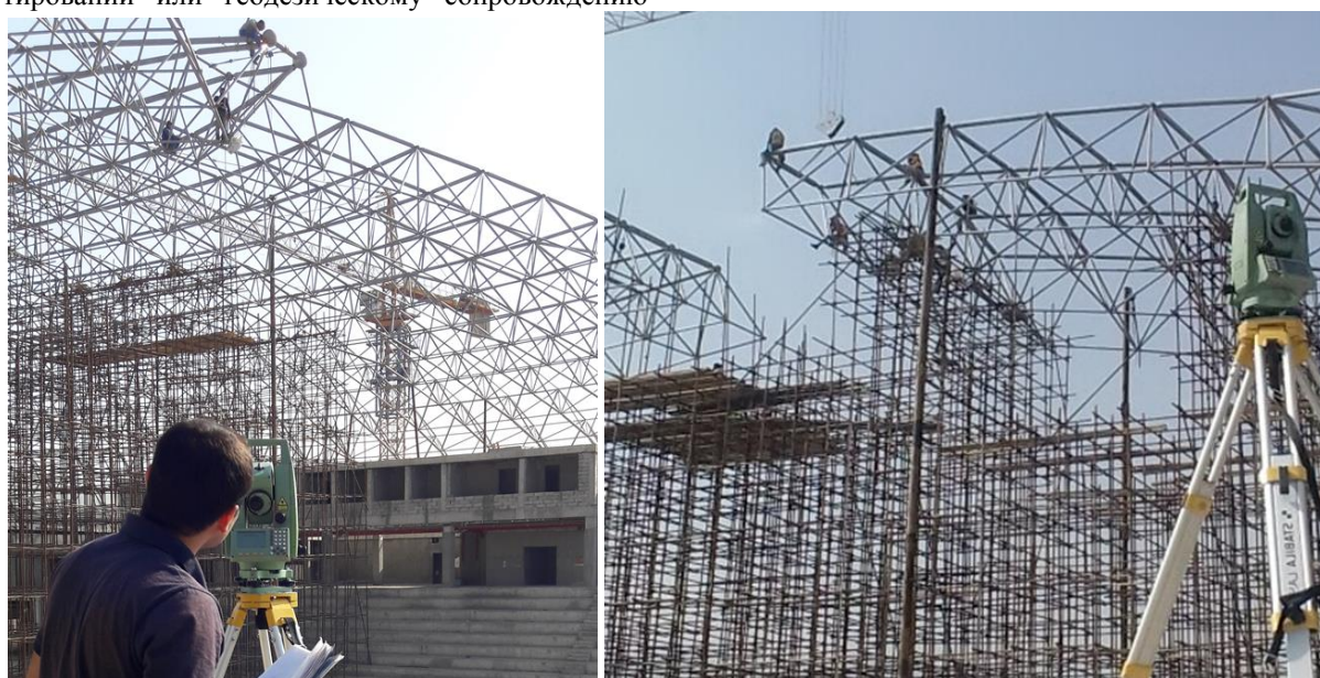
Рис. 6 Определение координат и отметок во время монтажа пространственной конструкции
