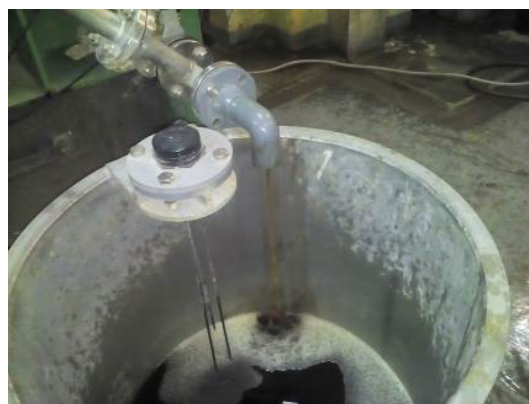
Рисунок 6 – Промежуточный бак-сборник фильтрата в первые 5 минут фильтрации пульпы выщелачивания
