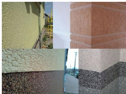
Рис.2 Оздоблення фасаду будинку штукатуркою
