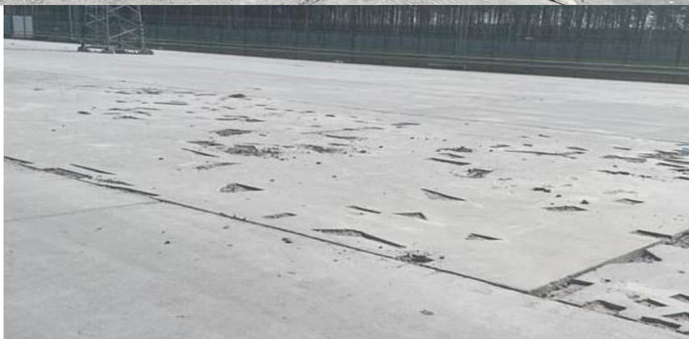
Рисунок 3 – ЦСВЯП - дефекти поверхні майданчику для захоронення відпрацьованого ядерного палива на 2021 рік ( facebook.com/olga.kosharna )
