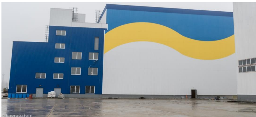
Рисунок 1 – Перший пусковий комплекс ЦСВЯП збудовано, Пресцентр НАЕК “Енергоатом” 22.12.2020
