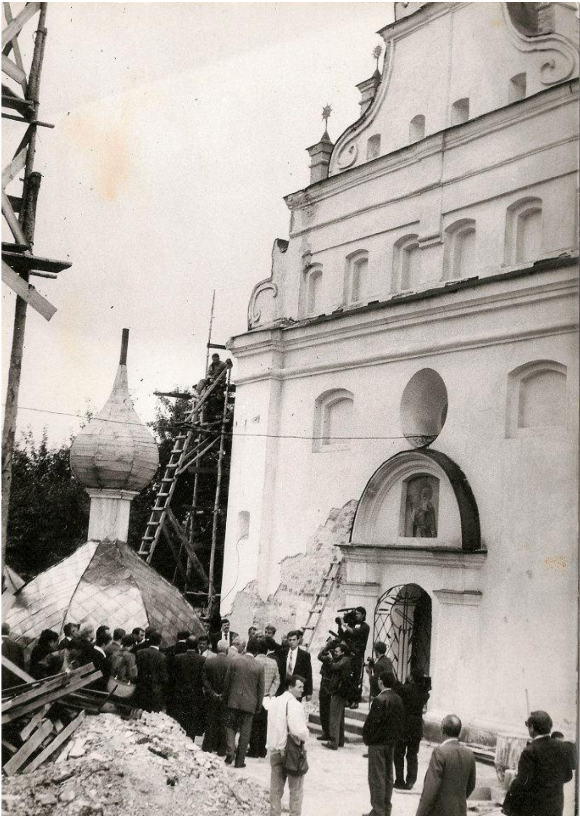
Реставраційні роботи 1993–1995 рр.
