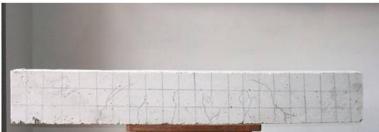
Рис. 6.3. фрагмент залізобетонної балки після випробування її на згин.
