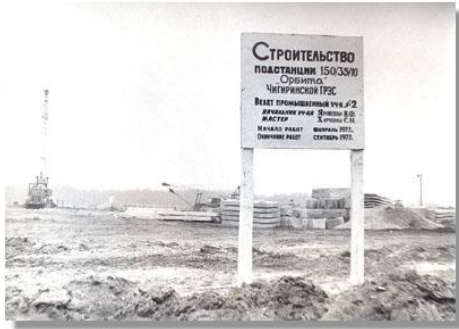
Фото 3. Будівництво підстанції Орбіта [9]
