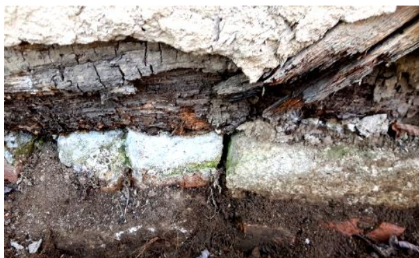
Цегла на місці просідання зрубу. Селянська хата. початок XX ст. с.Суботів Чигиринського району Світлина О.Мінської
