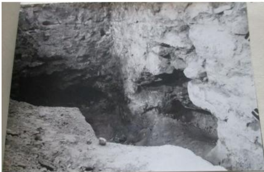
Проломи у фундаменті храму, через які, на думку П. Горішнього, було витягнуто домовину з останками Богдана Хмельницького. Світлини зі звіту експедиції 1971 р.
