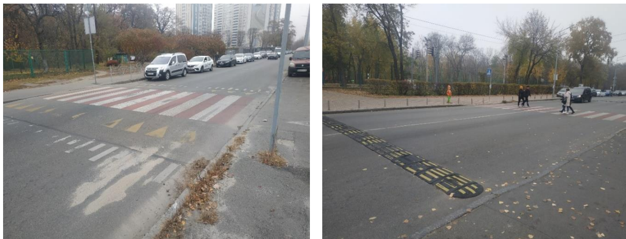
Рисунок 2 – Відрізок дороги із встановленими штучними дорожніми нерівностями типу I та типу II
