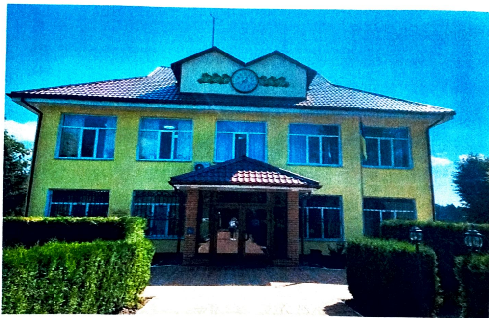
Рисунок 3.1 – Адміністративна будівля Корсунь-Шевченківського надлісництва
