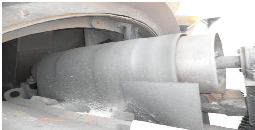
Рис. 4 – Сход конвейерной ленты с приводного цилиндрического барабана
