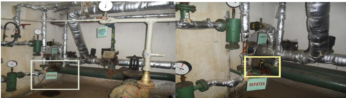
Рис. 2. Зовнішній вигляд (а) та вид на затворний клапан (б) системи автоматичного керування опаленням (КЗ «Лисичанська спеціалізована школа І-ІІІ ст. № 8»)
